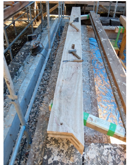
基礎の光付け作業
