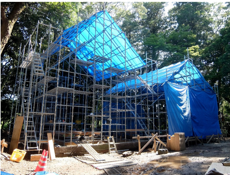
小屋組みが完成
